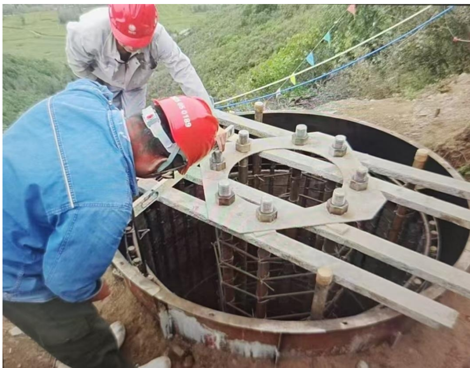
图 3-6 输电杆塔地基施工
