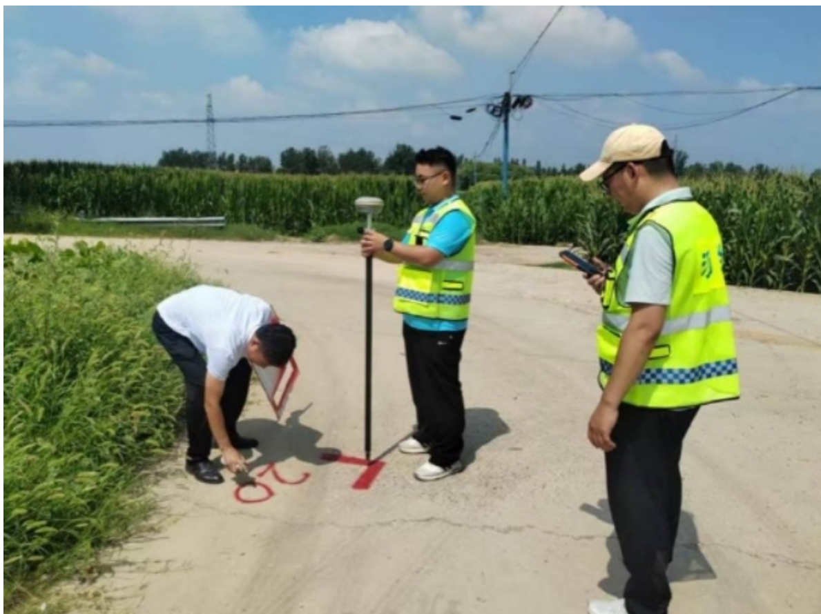
图 3-29 像控点的布设与数据采集
